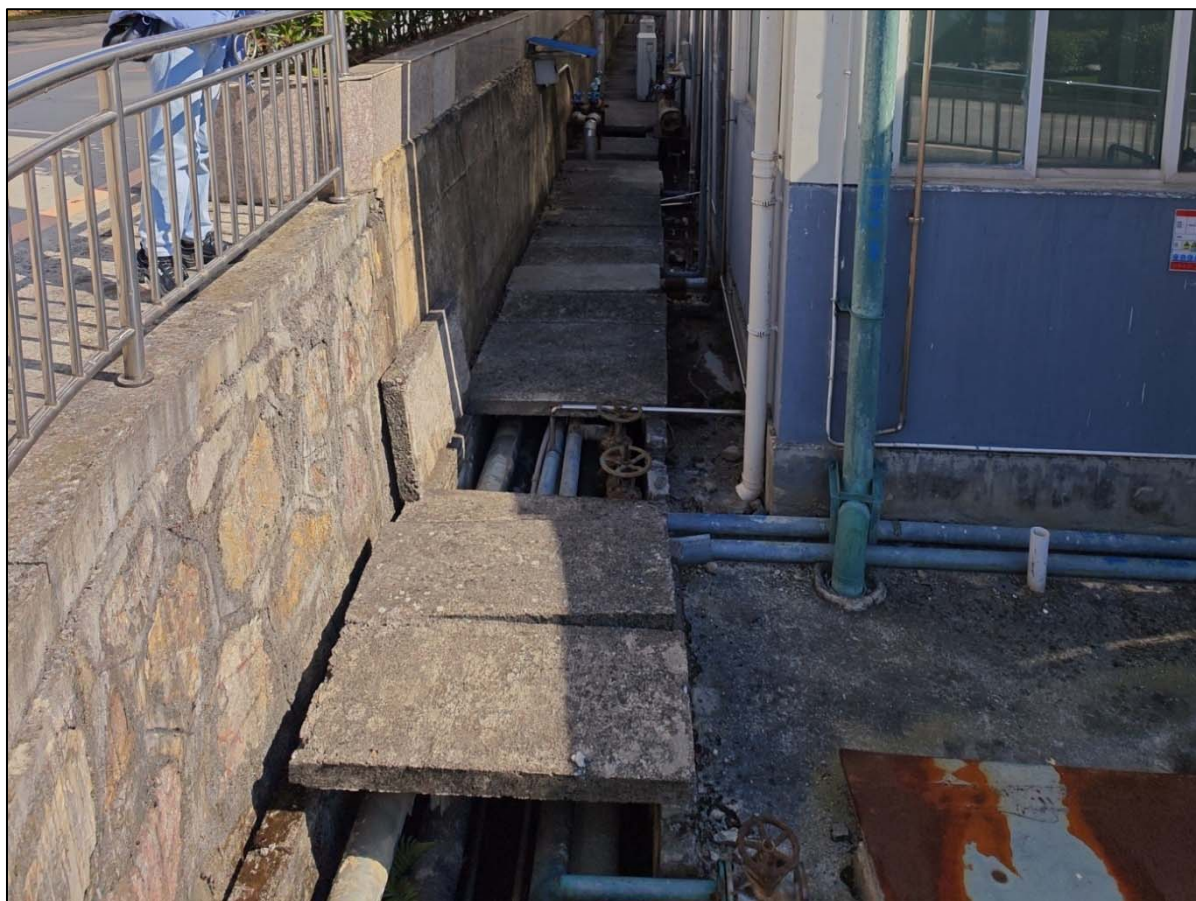
图 4.1-1 现场管道图片
